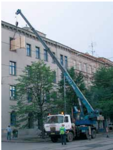
Instalace se neobešla bez pomoci těžké techniky.
